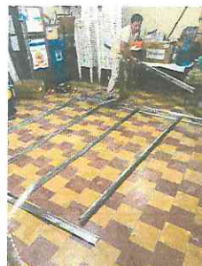
Foto 6: Construcción de cubículo en dirección.
