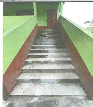
Foto 2: Reparación de gradas en Sexto A y sexto B.
